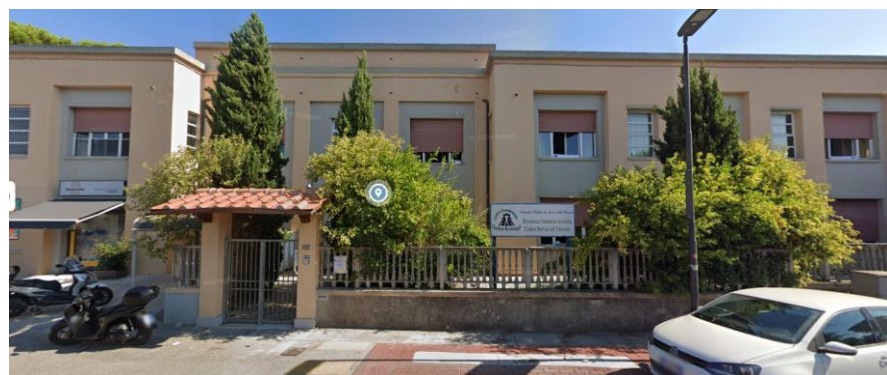
Fig. 2.1.xxi – Casa di riposo Matteo Remaggi Google Street View
