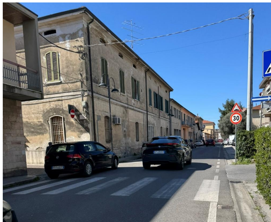
Fig. 2.2.xv – Marciapiede ed attraversamento inadeguato via della Pace Rilievo diretto META
