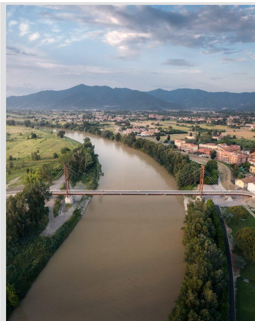
Il nuovo ponte ciclopedonale di Riglione facilita grandemente l'accesso ciclabile alla città di Pisa e dev'essere considerato un caposaldo della nuova rete leggera, basata su criteri di permeabilità selettiva (fonte www.terredipisa.it)
