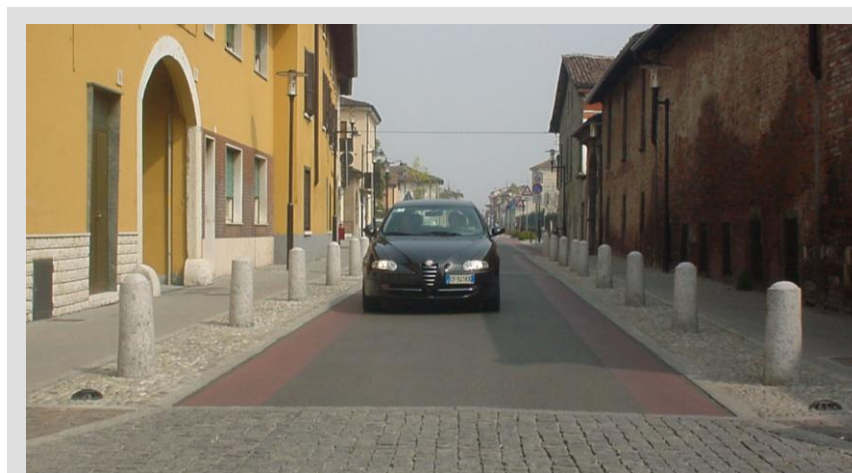
Ambito urbano centrale: franchi laterali polivalenti, ad uso ciclabile con funzione di riduzione ottica della carreggiata, realizzati con verniciatura dell'asfalto. Frazione di Fornaci, Brescia. Archivio META
