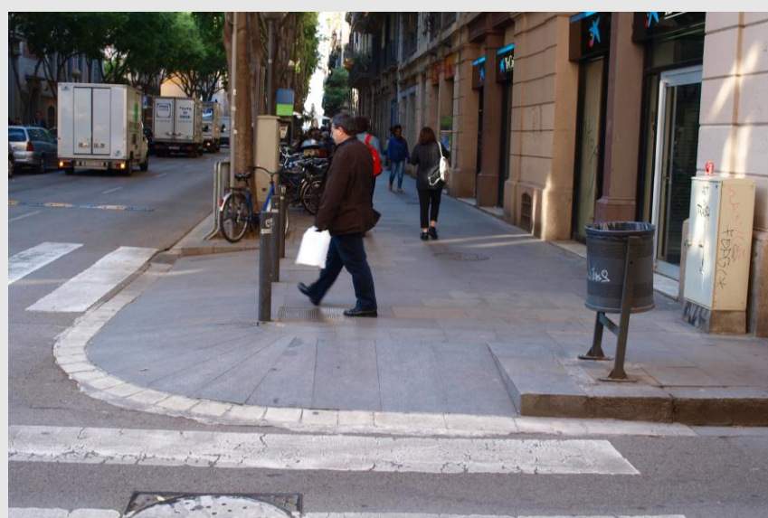
Esempio di risoluzione delle barriere architettoniche senza demolizione del marciapiede esistente a Barcellona
