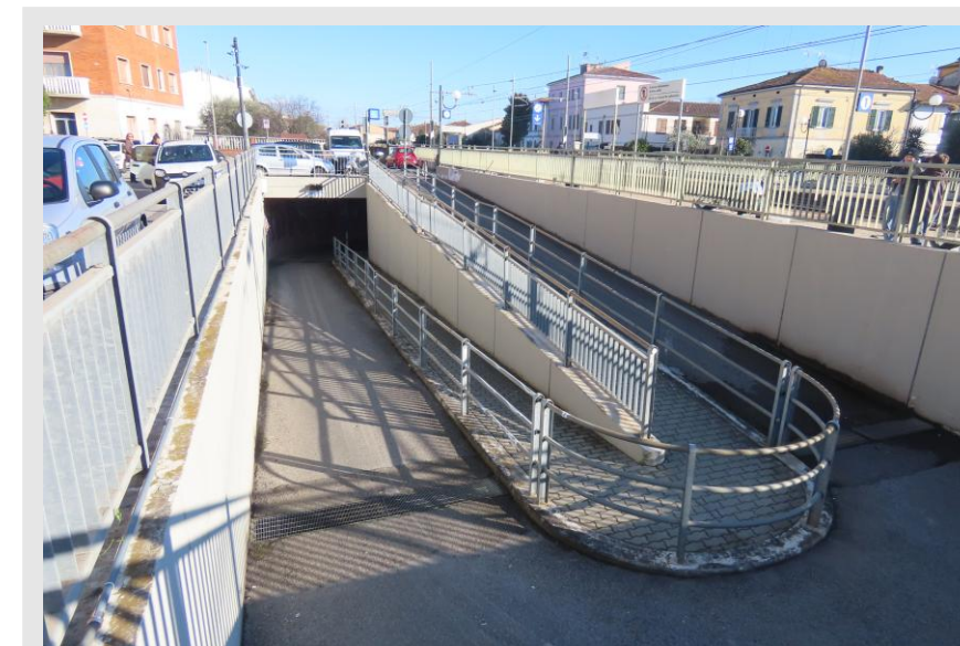
Il sottopasso ciclopedonale della stazione di Cascina.
