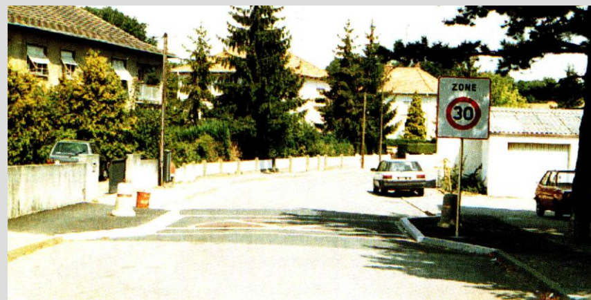
È importante che l'accesso alle zone residenziali venga delimitato in modo chiaro ed efficace, e ben segnalato all'attenzione degli automobilisti.
