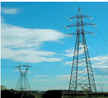
figura 2a : palo a fusto Y (sulla sx rispetto a chi legge) e palo a fusto piramidale (sulla dx rispetto al lettore)
