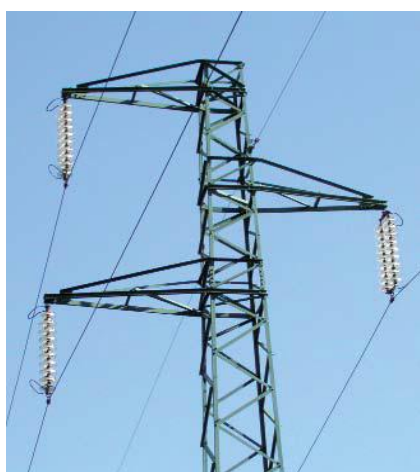
figura 6 : linea a semplice terna con isolatori sospesi
