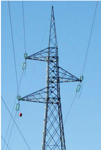
figura 3 : linea a semplice terna con isolatori rigidi
