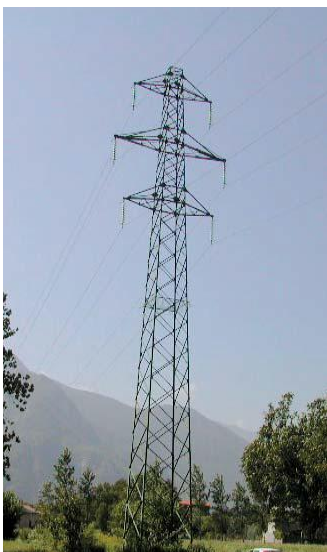
figura 4 : linea a doppia terna con isolatori sospesi
