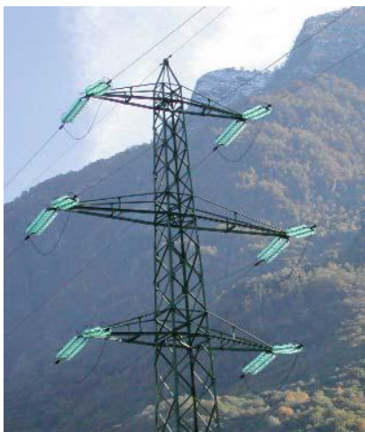
figura 5 : linea a doppia terna con isolatori rigidi
