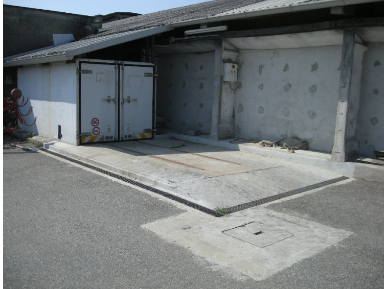
Foto 16: La cella per le carcasse con il piazzalino antistante dotato di griglia laterale per la intercettazione di ogni eventuale percolato per stoccarlo nello specifico pozzettone (visibile in primo piano)
