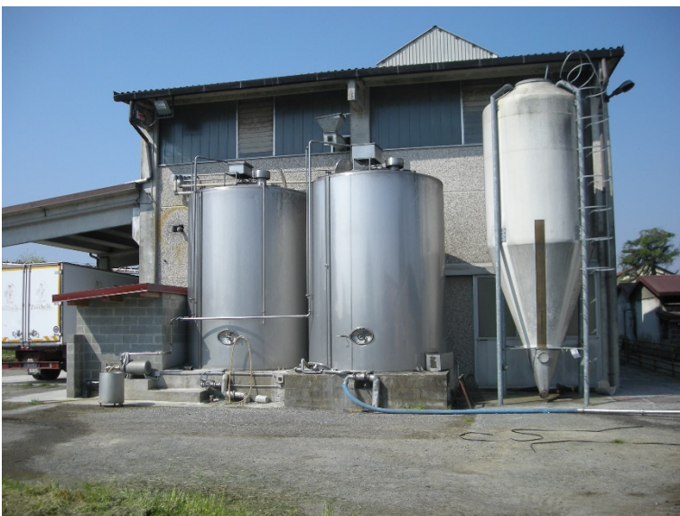
Foto 13: i serbatoi del siero ed il silo per il concentrato all'esterno della cucina. Alla sinistra il piccolo locale deposito disinfettanti
