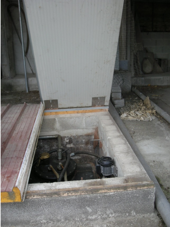
Foto 11: a sinistra la cisterna del gasolio interrata posta all'interno di un manufatto in cls. Ben visibile il pannello di copertura incernierato da un lato per una facile e sicura apertura.
