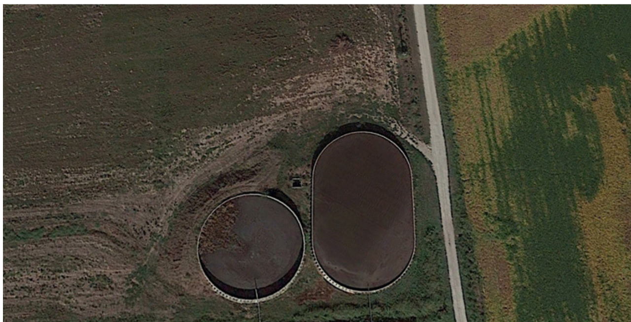
Figura B7 – Visione dall’alto delle due vasche di accumulo a pareti verticali
