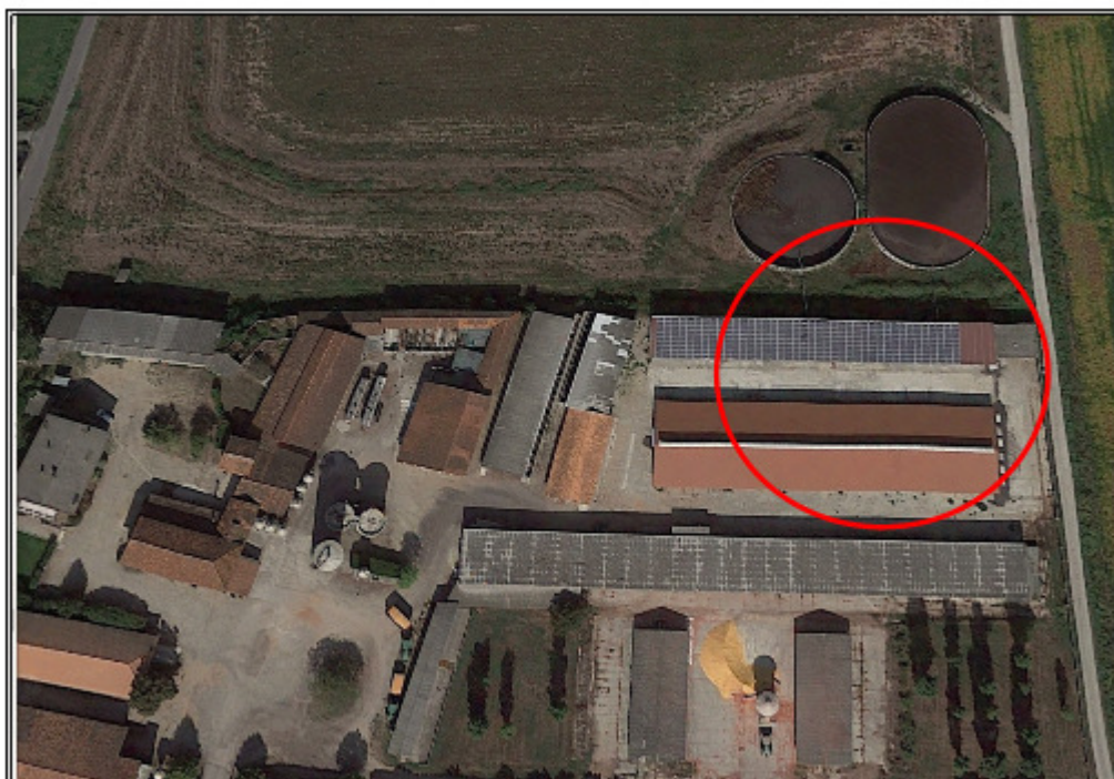
Figura B8 – Visione dall'alto dell'impianto fotovoltaico posto sulla copertura della STR07
