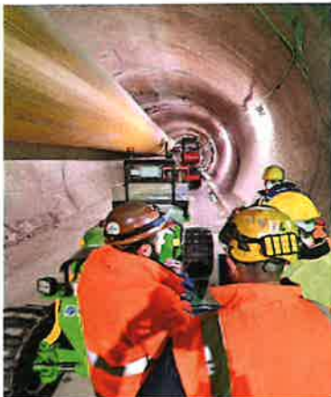
1 Il cantiere per gli scavi della linea dell'alta velocità Torino-Lione
