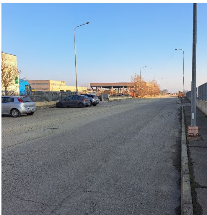
Foto n. 10 – Via dell'Agricoltura, Lotto A3 (sx) e Lotto C1 (dx)
