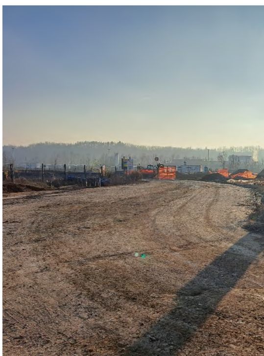
Foto n. 13 -Lotto B e cantiere TAV
