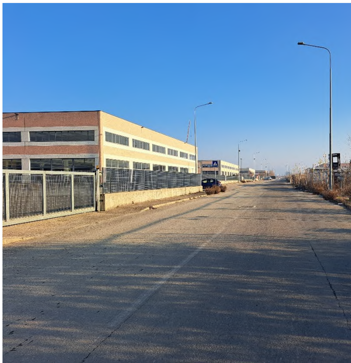
Foto n. 6- Via dell'agricoltura, Lotto A1 (sx) e Lotto B (dx)
