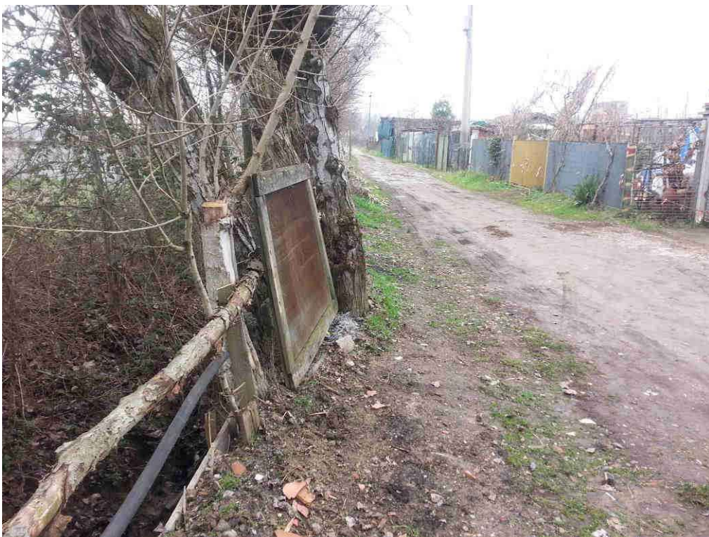
Figura 8-6 - Fra le sezioni 160 e 140 l'ampliamento della sede stradale è avvenuta a spese del corso d'acqua. (foto 2063-20160213_132444)
