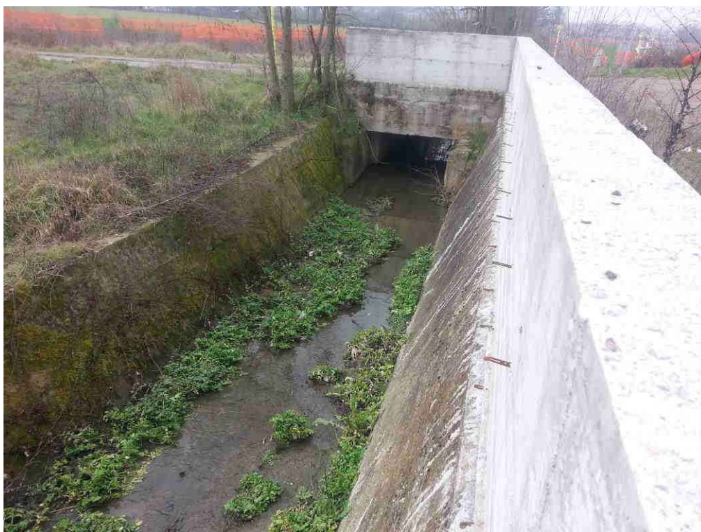
Figura 8-4 - Attraversamento GAZ01 visto da monte. Si vede il risvolto del muretto in destra tale da formare una sorta di parapetto sull'attraversamento. (foto: 2063- 20160213_121212).
