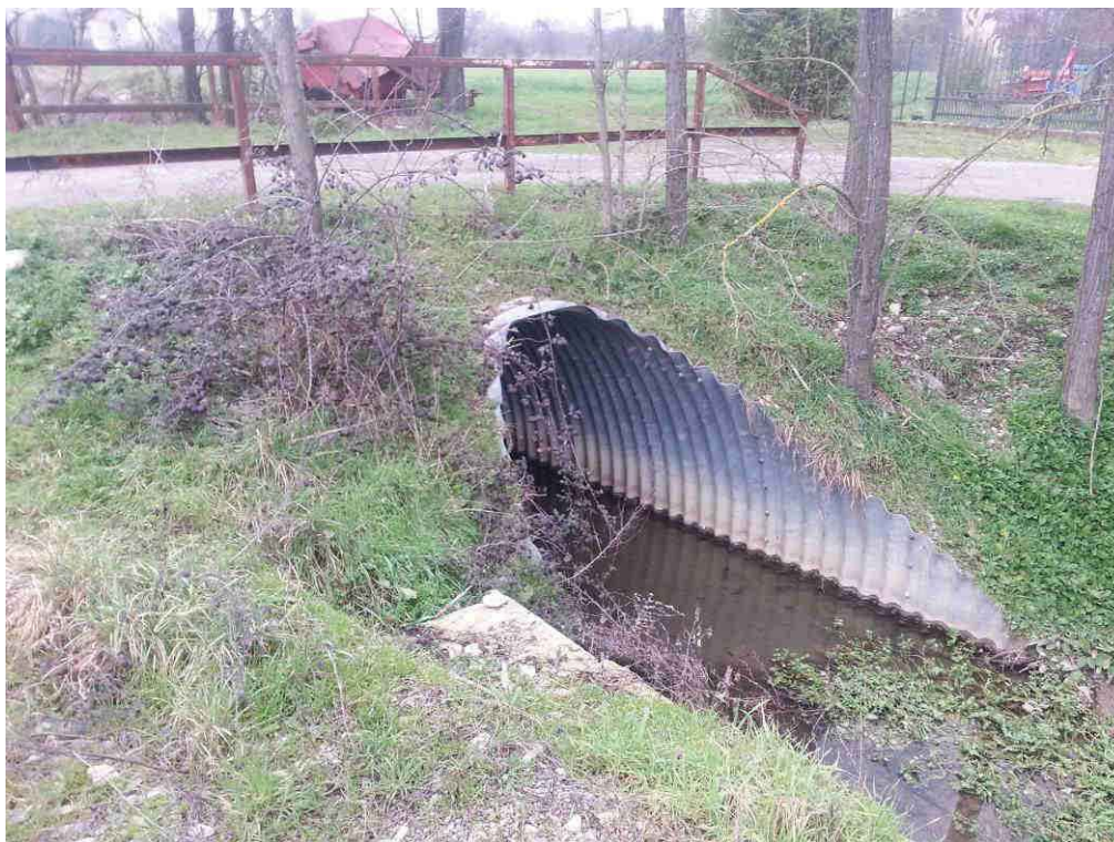
Figura 8-11 – Manufatto di attraversamento GAZ03 alla sezione 80, visto dalla sponda sinistra. (foto 2063-20160213_134933)
