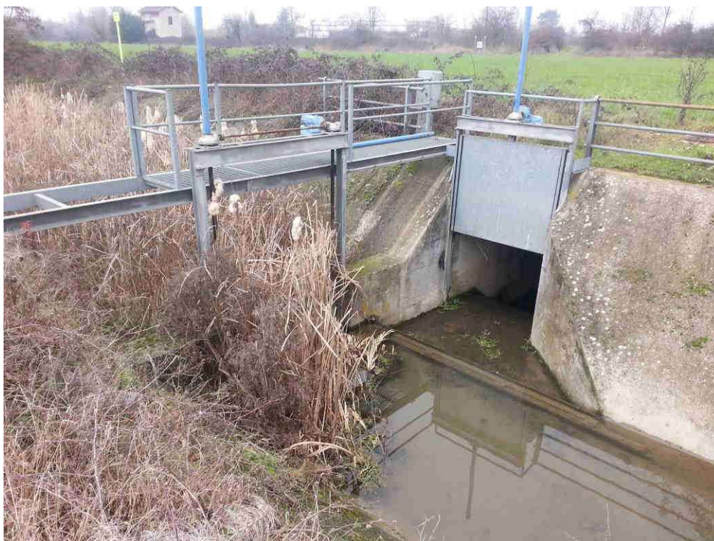
Figura 8-12 – Manufatto di controllo alla sezione 70. Il Rio Gazzo defluisce da destra a sinistra della foto. L'alveo è sbarrato dalla struttura trasversale foggata a gaveta e recante un'apertura sul fondo controllata da paratoia piana (non visibile dietro al cespuglio). La portata in arrivo viene decurtata della portata richiamata dallo scaricatore attraverso l'apertura controllata dalla paratoia che immette nel canale scaricatore. (foto 2063- 20160213_135010)
