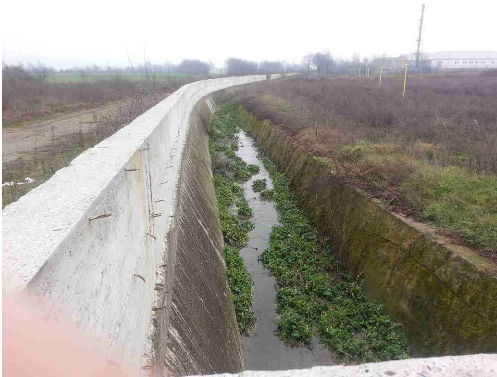
Figura 8-3 – Vista verso monte del Rio Gazzo a monte dell'attraversamento GAZ01. Il tratto è incanalato entro sponde in cls. Si vede il muretto realizzato dalle ferrovie in sponda destra per contenere le piene. (foto: 2063- 20160213_121150)
