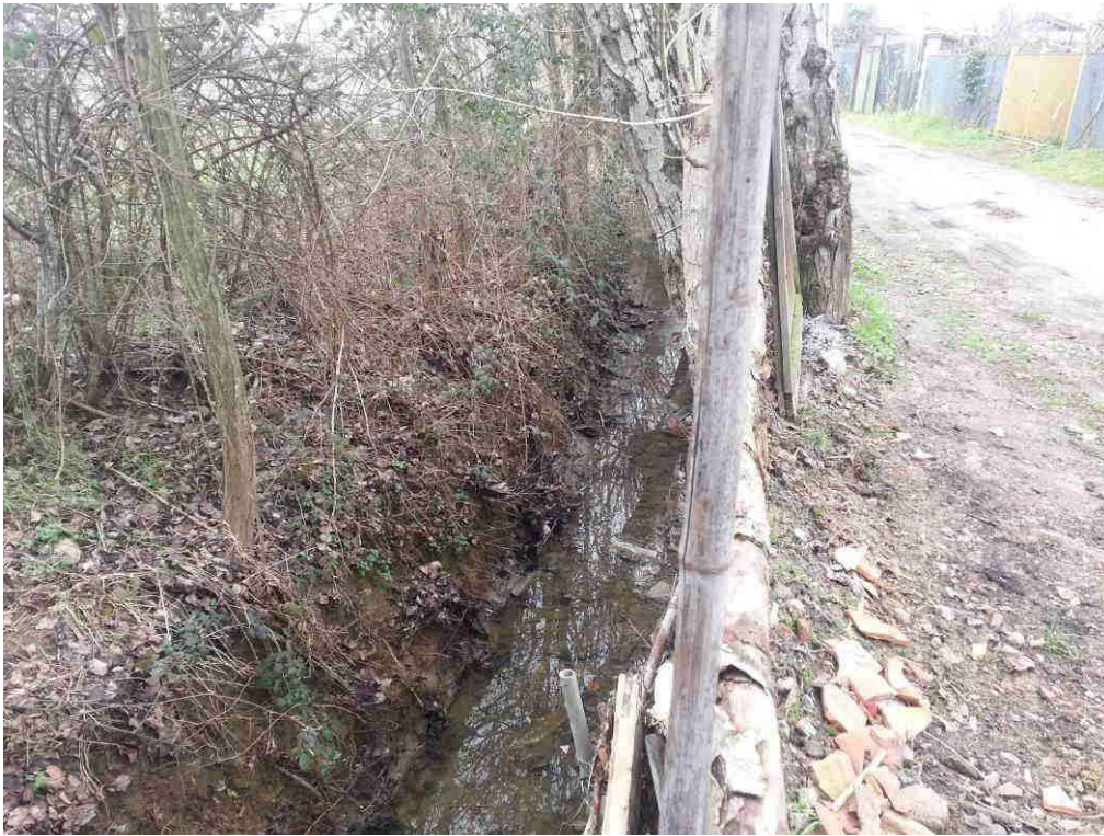
Figura 8-5 Forte restringimento di alveo fra le sezioni 160 e 140 a causa dell'ampliamento della sede stradale a spese del corso d'acqua. (foto 2063-20160213_132439)
