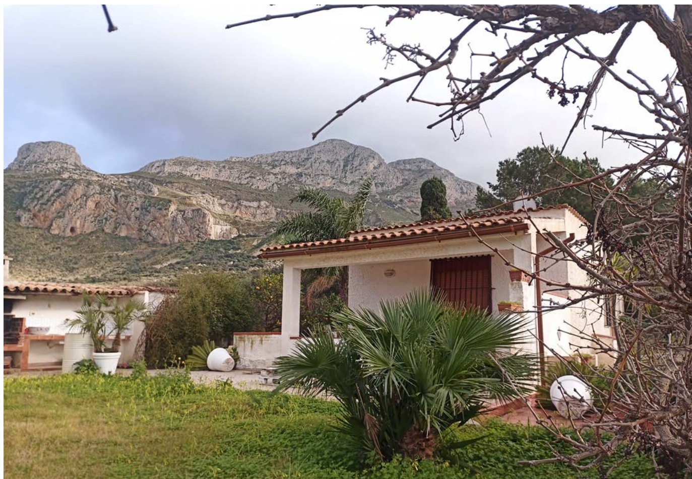
VISTA VERSO SUD-EST
