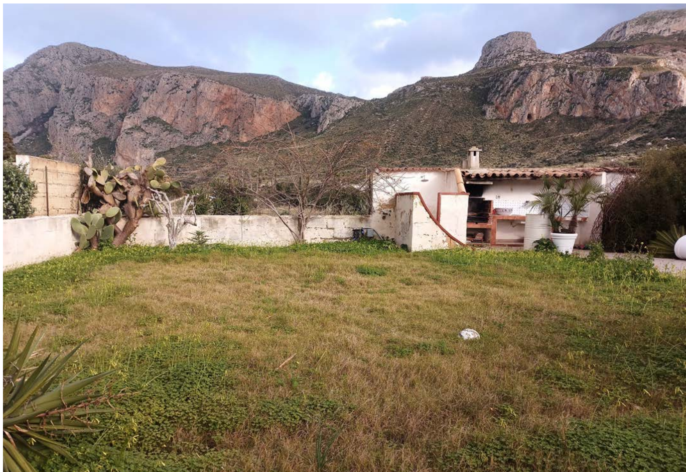
VISTA VERSO EST
